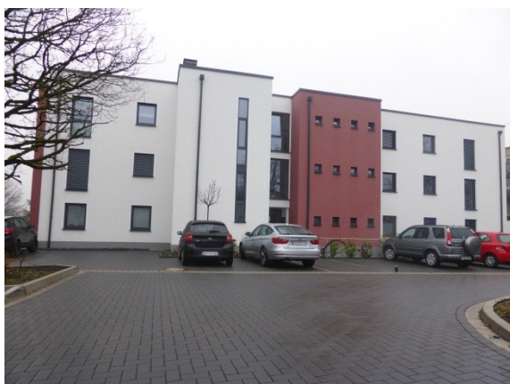
Abbildung 33: Sanierte und unsanierte Gebäude an der Breslauer Straße
