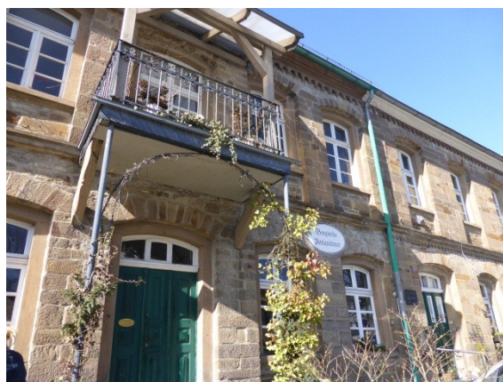
Abbildung 35 Kombination Bergischer Schiefer und Fachwerk als Fassade und Grauwacke als Sockel
